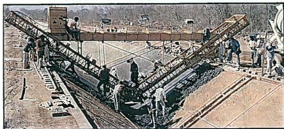
写真上/ 水路片斜面舗装 下/ 水路両面舗装
