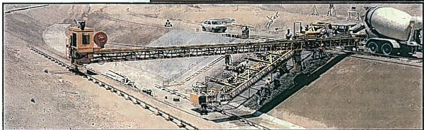
写真上/ 水路片斜面舗装 下/ 水路両面舗装
