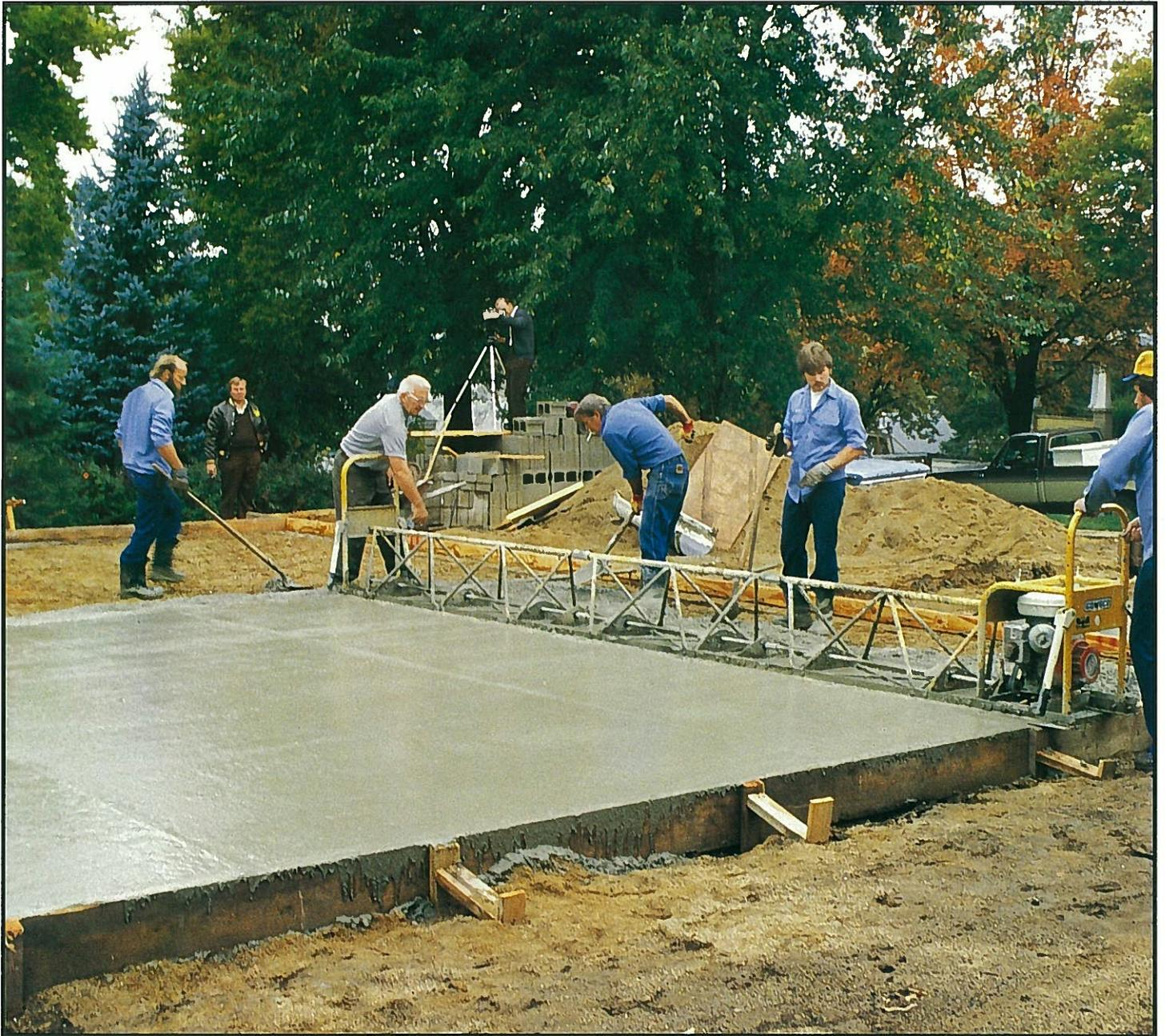
ゴメコ社製ホークアイ・スクリードは、車道、街路、飛行場エプロン、その他平坦なスラブなどの様々なコンクリート打設現場の仕上げ用機械として設計されています。このホークアイには、MV18型のエンジン駆動式と、AV-18型(オプション)のエア駆動式の二種類の機種があります。
