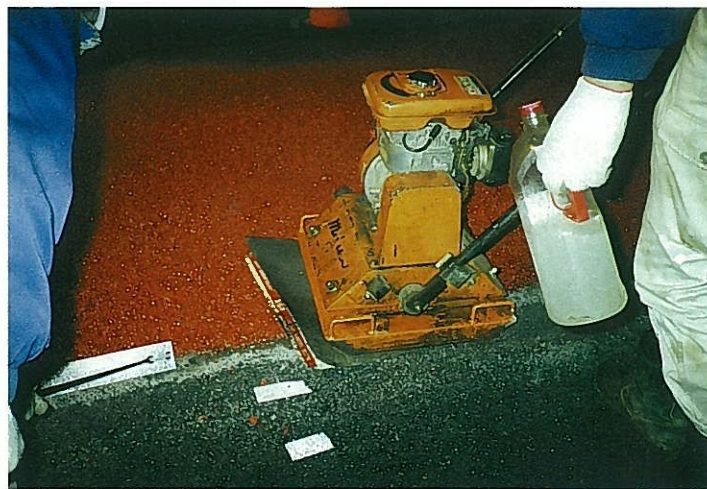
カラー排水性舗装混合物転圧中の振動プレート
